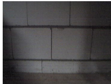
Fot.2. Fragment ściany szczytowej poddasza nieogrzewanego
